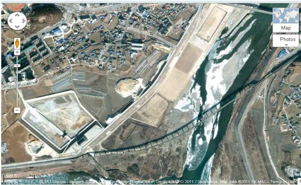
〈그림 IV-5〉 영월천연가스발전소 주변 전경(팔괴 1리).
