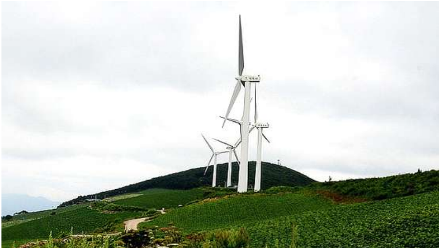
[그림 3-4] 대관령 풍력발전설비
