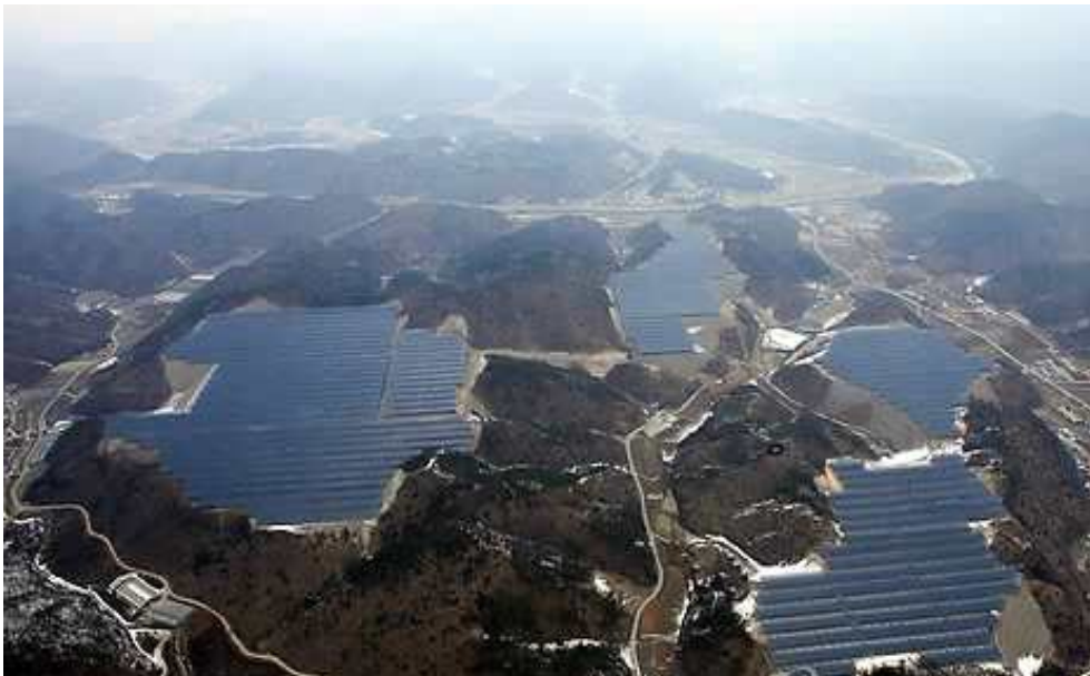
[그림 3-5] 영월군 태양광 발전설비
