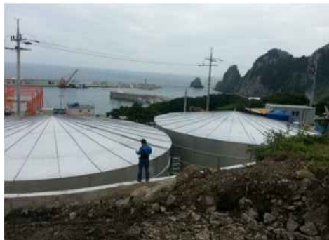
<그림 6.5> 스테인리스 탱크를 이용한 빗물 저장시설 개념도
