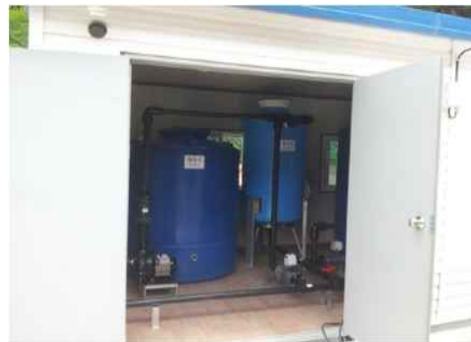
<그림 6.6> 지붕의 빗물을 집수관을 통해 컨테이너 저장 후 용수활용
